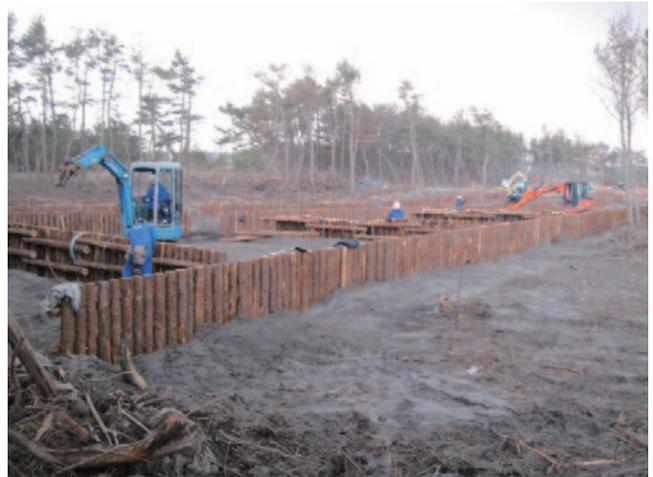
写真-9. 静砂垣の施工状況(三沢市四川目, 2012年4月29日)。津波被害を受けたクロマツ材は丸太として静砂垣に利用される他に、チップ化して植栽地のマルチングにも使われている。
