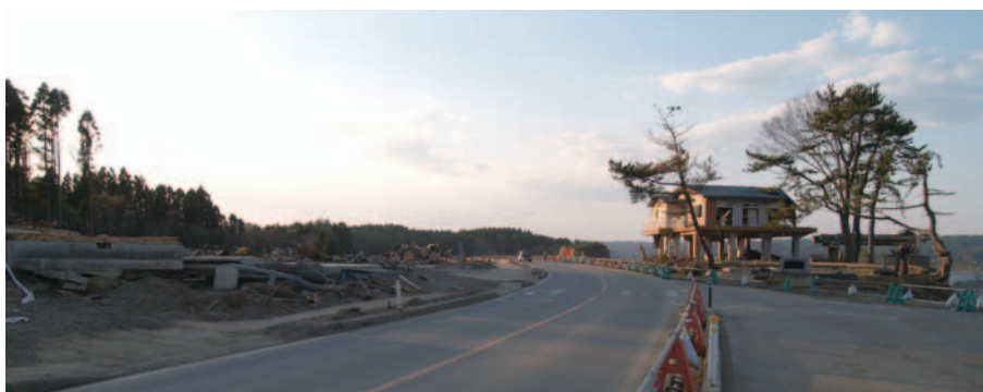
図-3. 高台での建物被害 1(岩手県野田村十府ヶ浦, 2013年4月12日)
