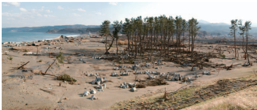
図-7. 破壊された防潮堤と失われた海岸林(岩手県野田村十府ヶ浦, 2013年4月12日)
