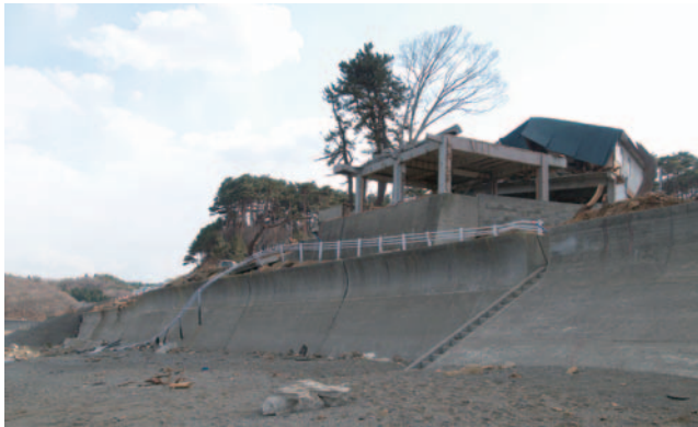
図-4. 高台での建物被害 2(岩手県野田村十府ヶ浦, 2013年4月12日) 前の写真の建物を海側から眺めたもの。防潮堤の高さ: T.P.+10.3m (T.P.: Tokyo Peil, 東京湾平均海面)。
